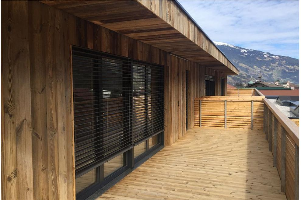
Les stores à lamelles orientables de la gamme AS permettent une réfraction optimale de la lumière grâce à la forme en "S" des lames. La forme des lamelles, d'une largeur de 65 ou 95mm, est étudiée pour atténuer le bruit et les reflets de lumière. Par ailleurs les perforations des lames sont réduites afin de limiter le passage de la lumière.
